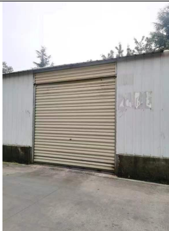
一般固废暂存间
