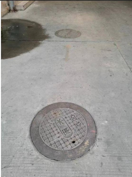
隔油池+预处理池
