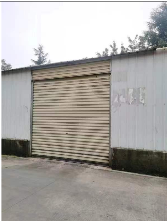
一般固废暂存间
