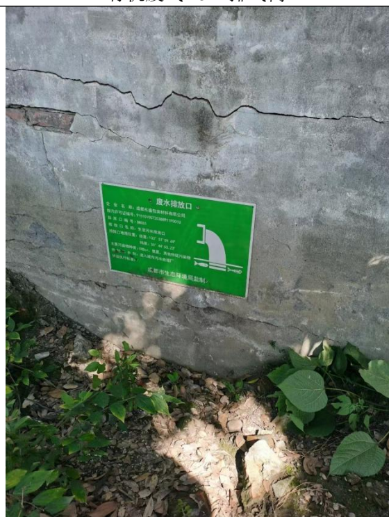
废水排放口及标识牌
