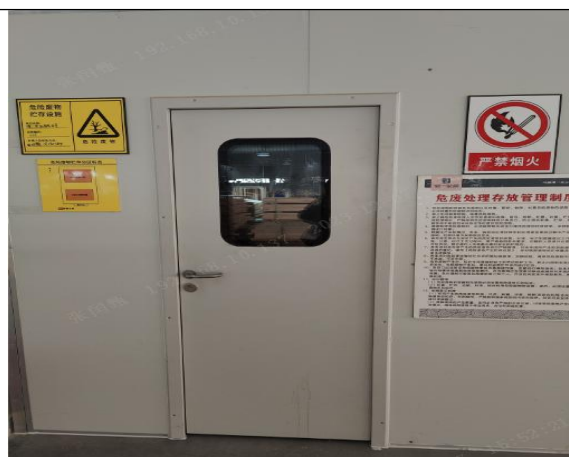
危废暂存间外部
