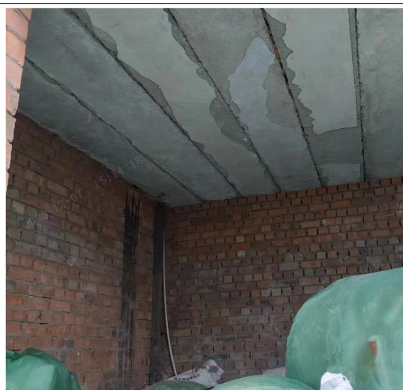
一般固废暂存间内部
