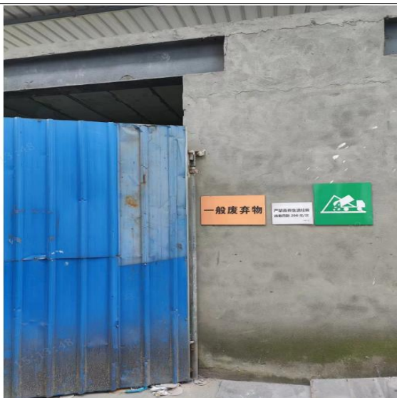
一般固废暂存间外部
